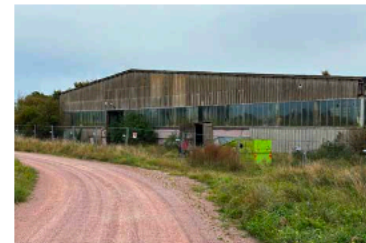
Planer finns att riva den gamla Ytongfabriken och bygga nytt. Men den planen är nu pausad. FOTO: ANDREAS YNGVESSON
