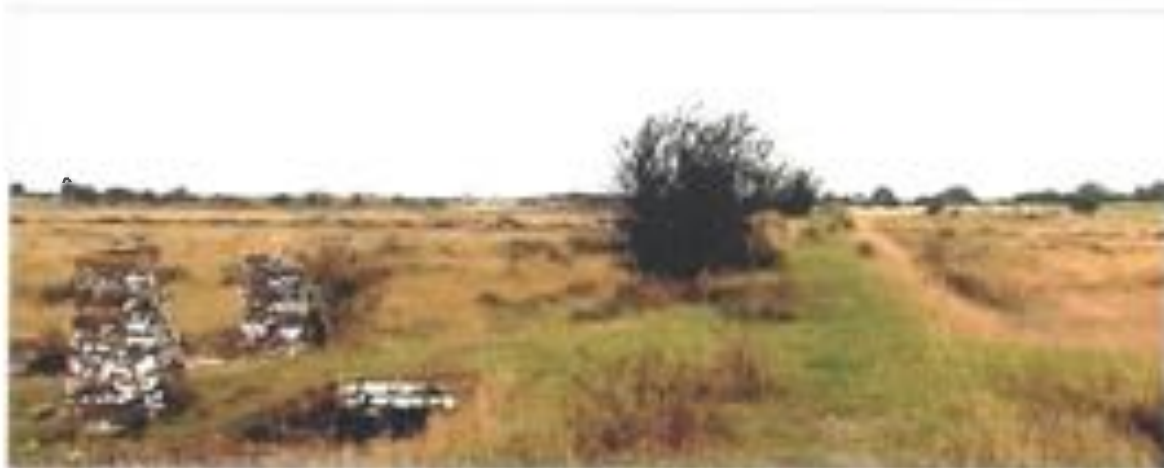
Figur 8. Grindstolpar och en äldre väg över smalspårsbanken på delsträcka 13, lägg också märke till den av sten byggda trumma under överfarten.
