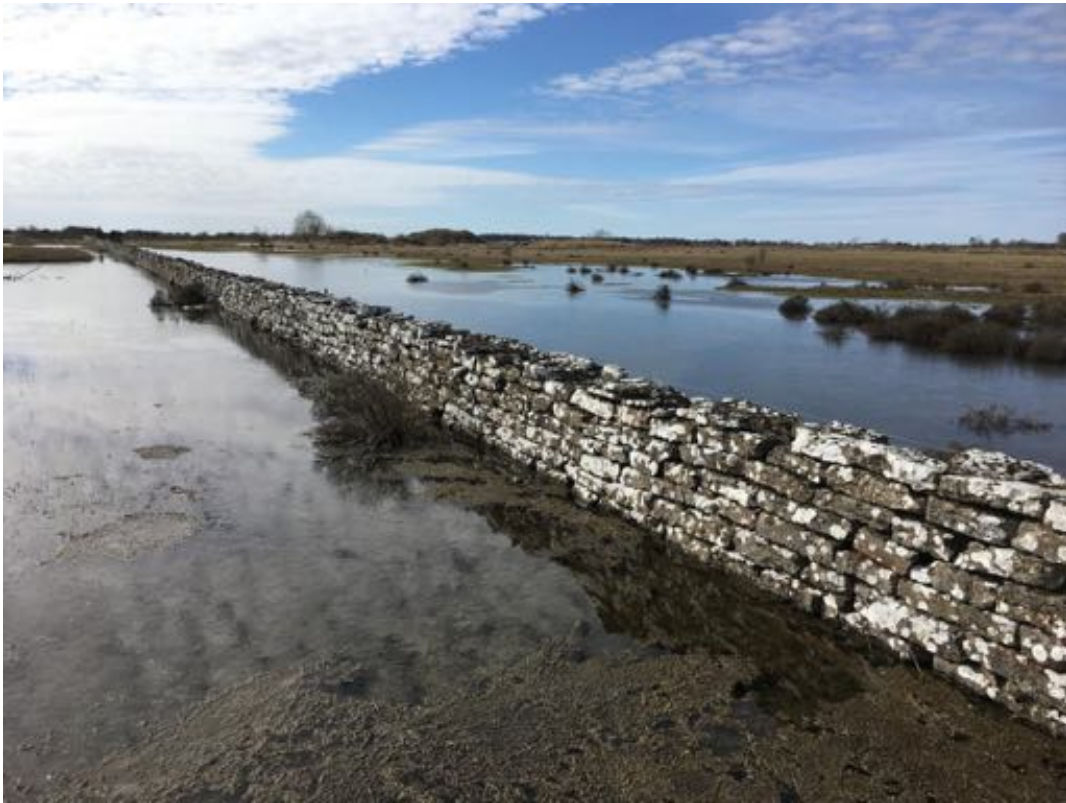
Genombrott stenmur Övra Segersta station
