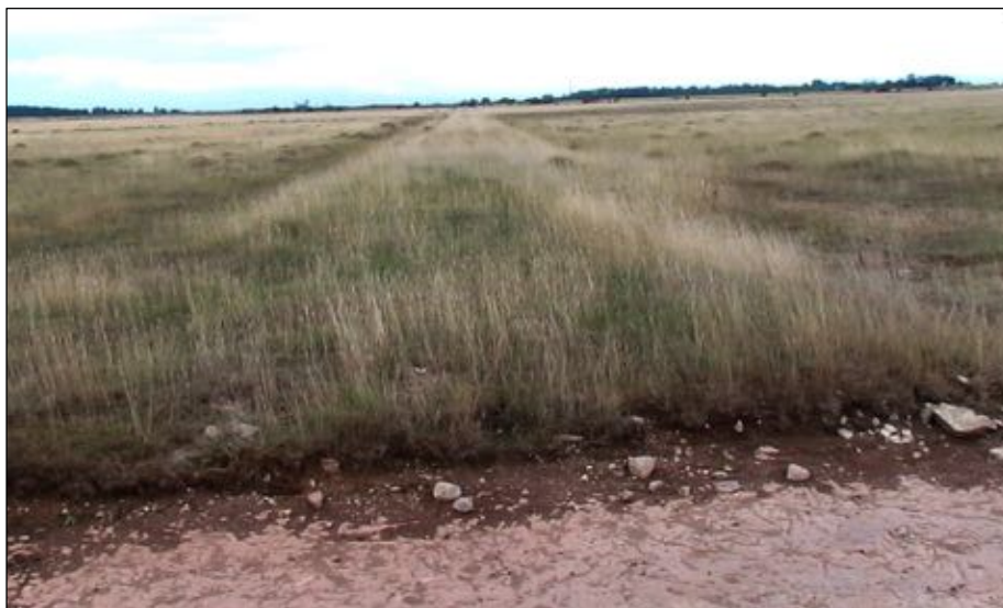
Bild 12. Delsträcka 10, en större bruksväg skär av banvallen gräns mot sträcka 11. Brukningsvägen föreslås för transporter i samband med kommande anläggningsarbete.
