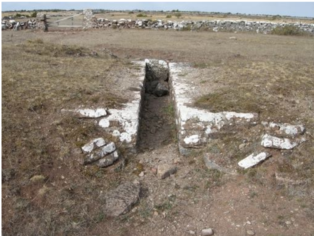
Bild 7. Kalkstenstrumma som leder vatten från väster till öster genom banvallen. Enkel reglering av vattenståndet med kalkstensplattor. Många flera liknande finns och är orensade. Konsekvenser av att rensa befintliga trummor samt anläggande av nya bör utredas vidare- Mörbylånga kommun
