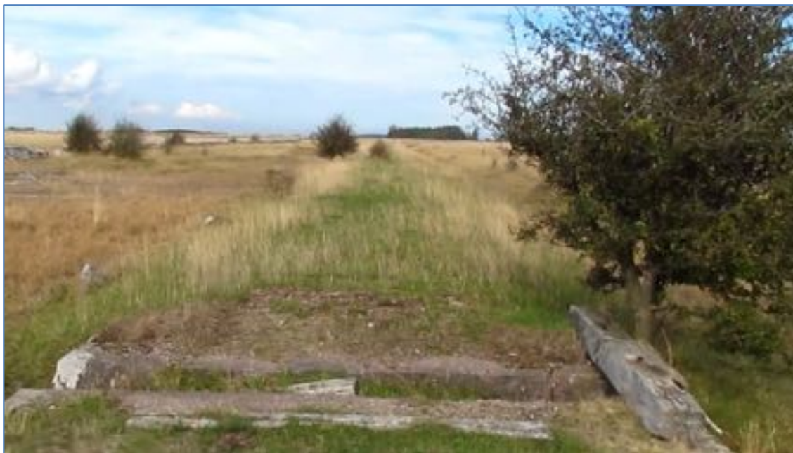
Bild 5. En öppen trumma leder vatten genom banvallen i södra delen av sträcka 6.
