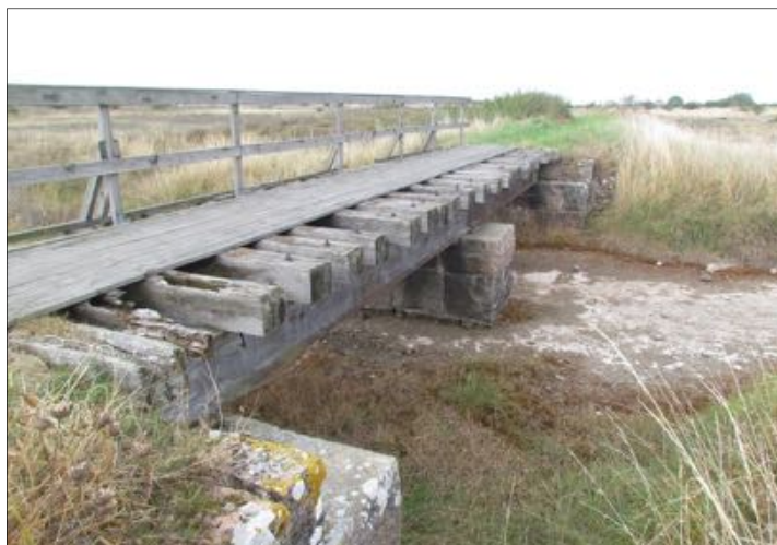
Bild 13, En 11 meter lång järnvägsbro över ett för dagen uttorkat vattendrag. En ny bro, (Bro 1- anmälan om vatten verksamhet) i samma stil ersätter den gamla.
