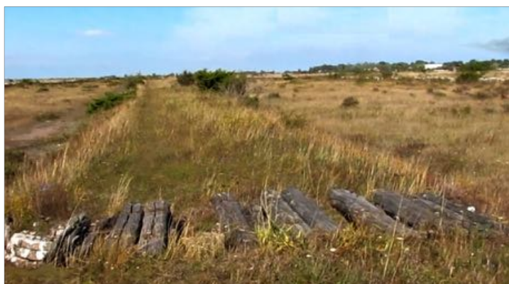
Bild 20. Delsträcka 15, en öppen trumma i banvallen täckt med sliprar för att komma över. Denna trumma är av god status och kan ligga kvar i vallen.
