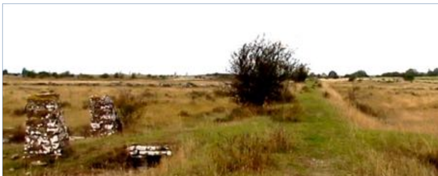
Bild 14 Grindstolpar och en äldre väg över smalspårsbanken lägg också märke till den av sten byggda trumma under överfarten.
