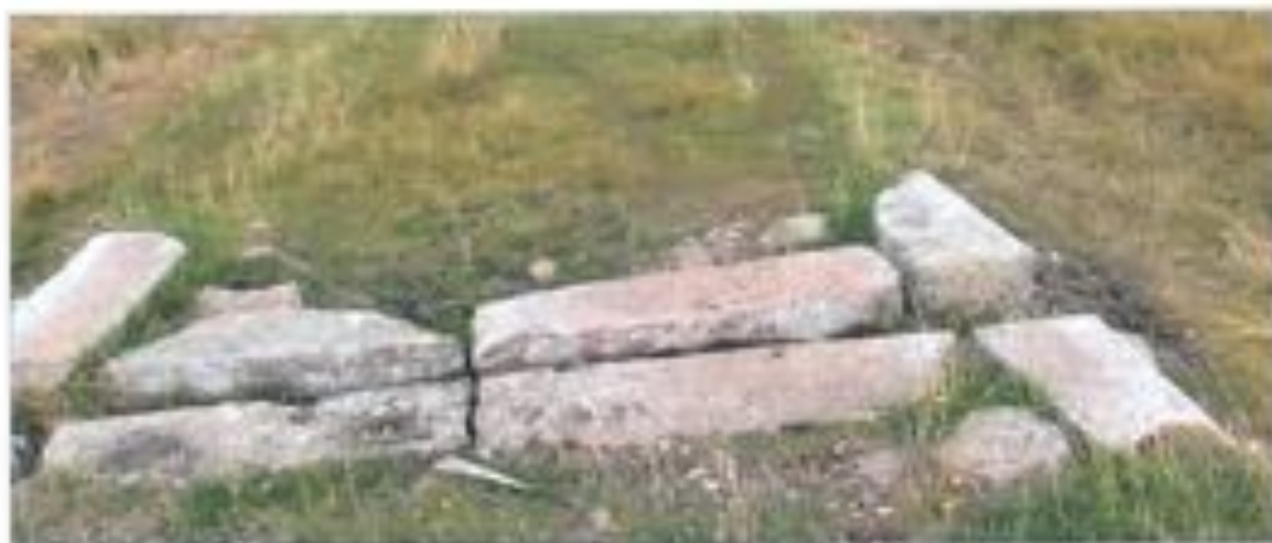
Figur 5. En öppen stensättning för avvattning genom banvallen, delsträcka 10.
