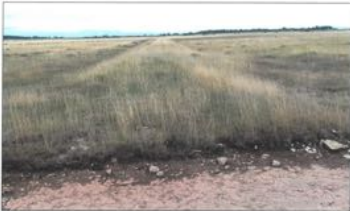
Figur 6. En större bruksväg skär av banvallen gräns mot sträcka 11. Vägen föreslås för transporter i samband med kommande anläggningsarbete.
