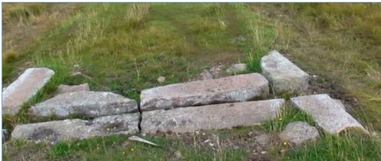
Bild 10. Delsträcka 10 en öppen stensättning för avvattnings genom banvallen.
