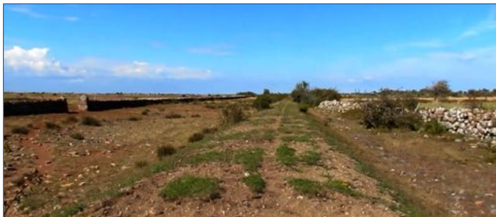
Bild 26. Sträcka 19, Mycket ytligt grus med påverkan av betesdjur. En anlagd öppning i stenmuren väster ut.
