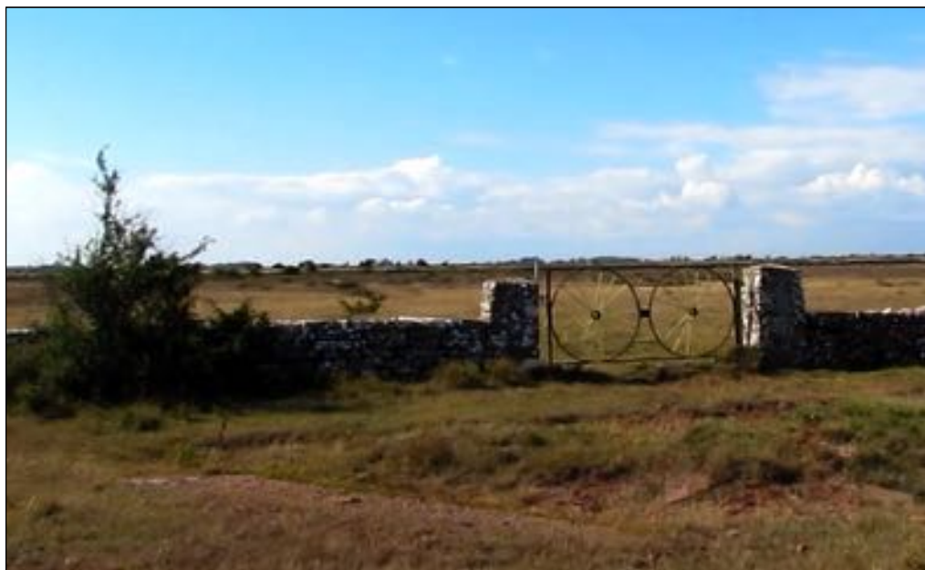
Bild 22. Delsträcka 16, en grind i stenmuren ut mot alvarsmarken i väster.
