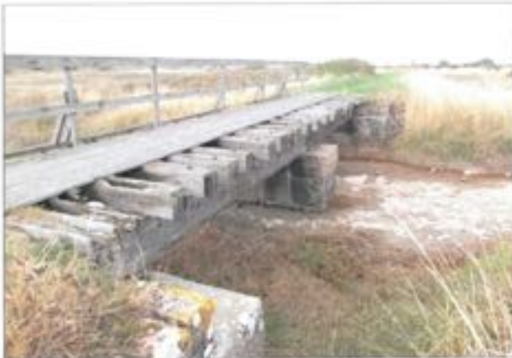
Figur 7. En 10 meter lång järnvägsbro över ett här uttorkat vattendrag, fundamenten behålls och en ny bredare bro med räcke på båda sidorna monteras.
